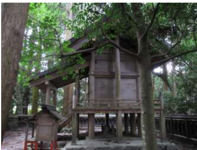
《神明造の本殿と本殿下の山神(石)。》
